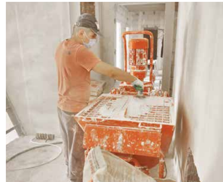
Механизированная штукатурка, которая сейчас применяется на Солнечном, существенно экономит время и силы строителей. Не нужно замешивать смесь и наносить её на поверхность, специалистам остаётся лишь разравнивать слои
