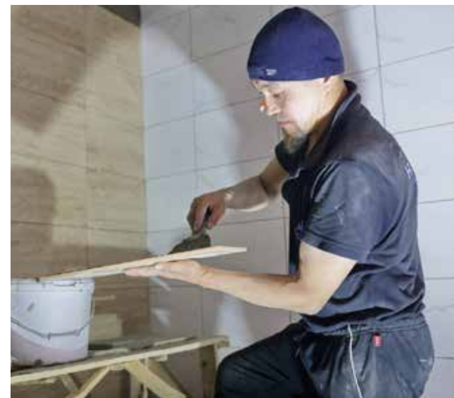
В 56-квартирнике в микрорайоне Подшибякина подрядчик занимается укладкой керамической плитки в санузлах. Следом за плиточниками идут штукатуры
