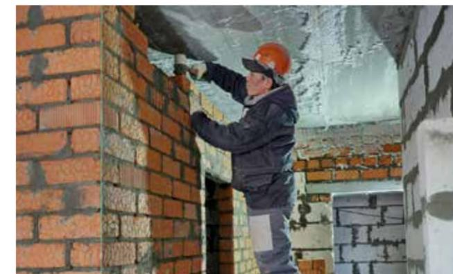
На стройплощадке в микрорайоне Геолог параллельно на трёх домах ведётся кладка межкомнатных перегородок
