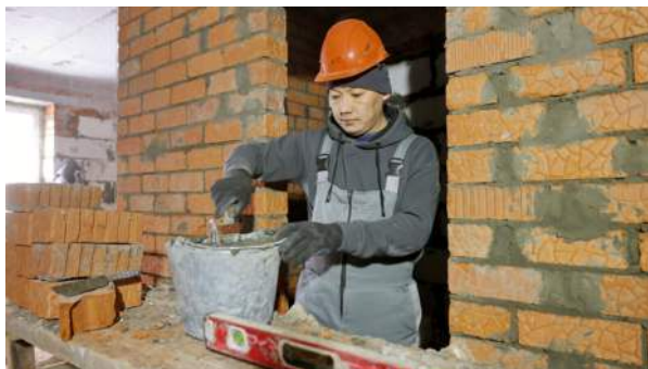
Внутри всех трёх зданий каменщики завершают возведение внутренних перегородок, параллельно идёт прокладка электросетей
