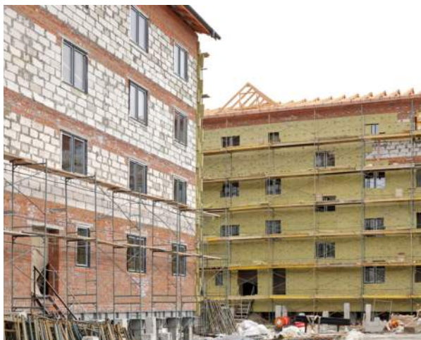
Снаружи многоквартирников монтажники занимаются утеплением и монтажом фасадов зданий, отделка выполняется из алюминиевых панелей
