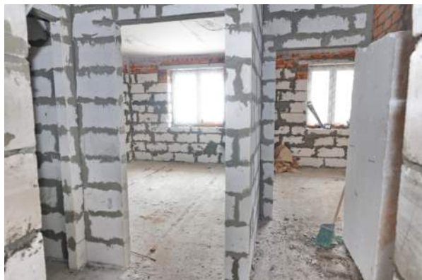
Внутри всех трёх зданий каменщики завершают возведение внутренних перегородок, параллельно идёт прокладка электросетей
