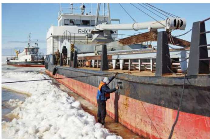
На теплоходе «Бухта» идёт покраска корпуса и подготовка навигационных знаков, которых на участке больше двухсот
