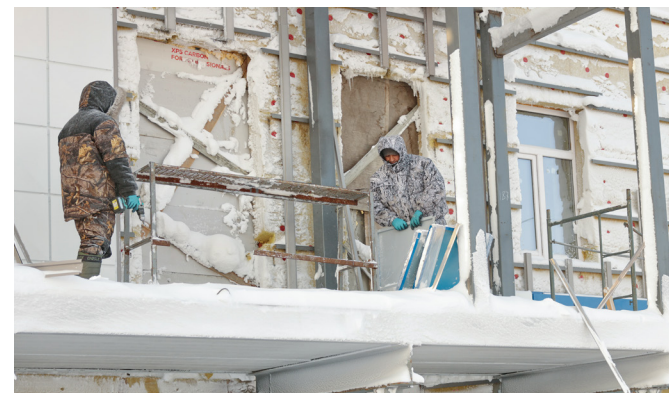
Строительная готовность здания филиала противотуберкулёзного диспансера - 60%. Одновременно ведутся внутренняя отделка, монтаж инженерных коммуникаций и фасадные работы
