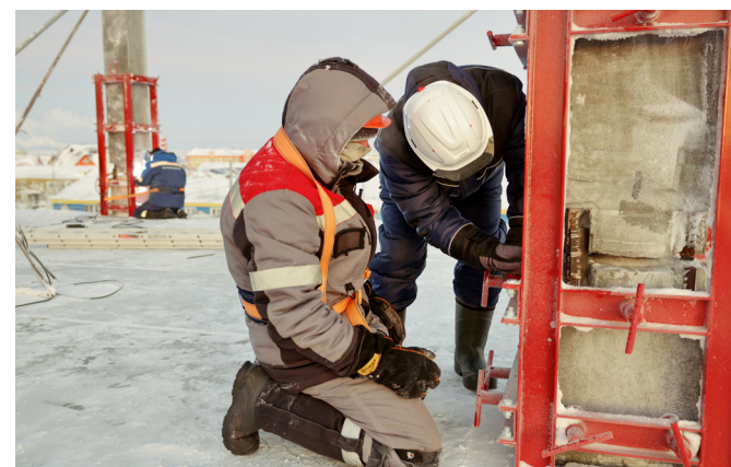
На стройплощадке стационара на 46 коек трудятся более 30 человек. Монтажники и сварщики занимаются возведением «скелета» будущего здания
