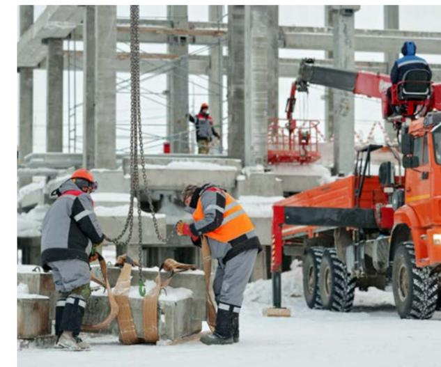
Для установки одной железобетонной колонны требуется пять монтажников и полчаса работы. Всего в каркасе здания будет 204 колонны
