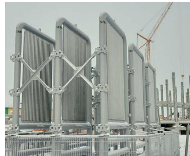
При строительстве стационара применили сложную систему термостабилизации грунтов, которая проходит под всем зданием и гарантирует, что почва наберёт необходимую мерзлоту
