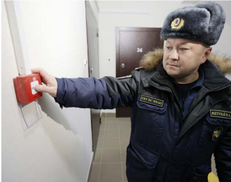
В подъездах домов установлены ручные извещатели. При нажатии на кнопку происходит активация пожарной сигнализации, и сигнал незамедлительно передаётся в пожарную часть
