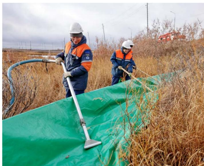
Разлившуюся «нефть» спасатели откачали вакуумным насосом в резервуар временного хранения
