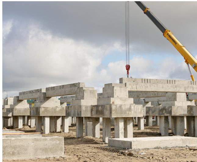
На строительной площадке стационара на 46 коек в районном центре завершён один из основных этапов - обустройство фундамента будущего здания
