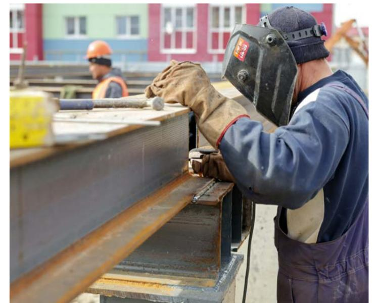
На втором корпусе работы идут чуть медленнее. Здесь бригада сварщиков занимается монтажом ростверка
