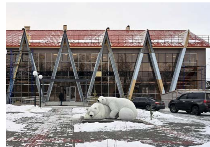
Фасад нового здания МФЦ стилизовали под чумы - национальное ненецкое жилище. Внутри здания завершены отделочные работы, благоустроена прилегающая территория
