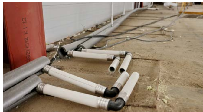
Система отопления в спортивном зале смонтирована на 80 процентов. Подрядчику остаётся установить радиаторы
