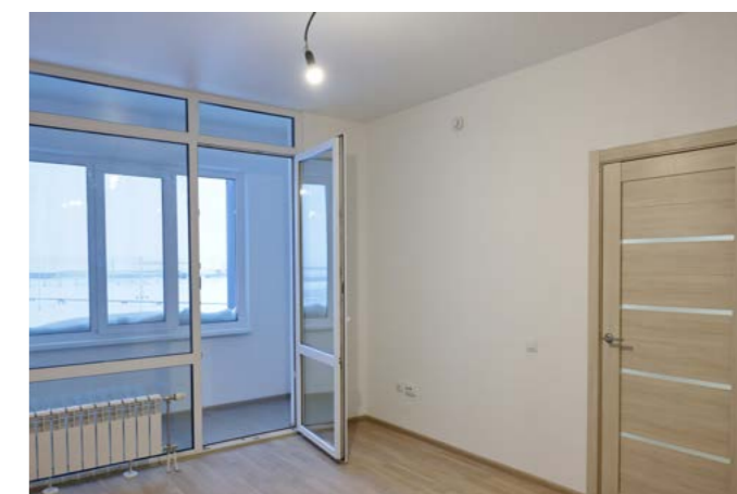
В кухнях и комнатах на третьем и четвёртом этажах лоджии отгорожены стеклянными перегородками
