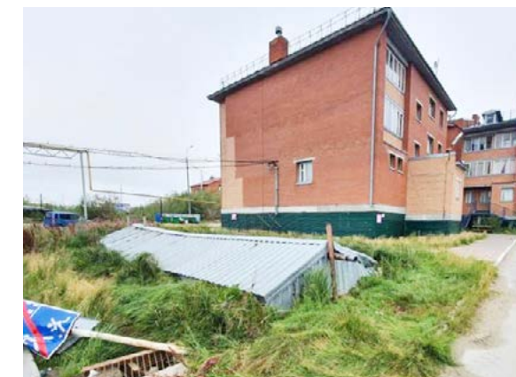
Септик около дома Пушкина, 10, давно требует ремонта, в этом году он был выбран в числе пяти других объектов для реализации, так что скоро эта картина уйдёт в прошлое
