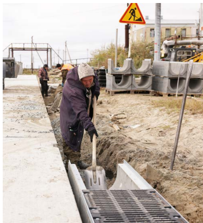
Завершается капремонт дорожной сети в микрорайоне Маргулова, кроме обновлённой «дорожной одежды», здесь появилась система водоотведения и тротуары
