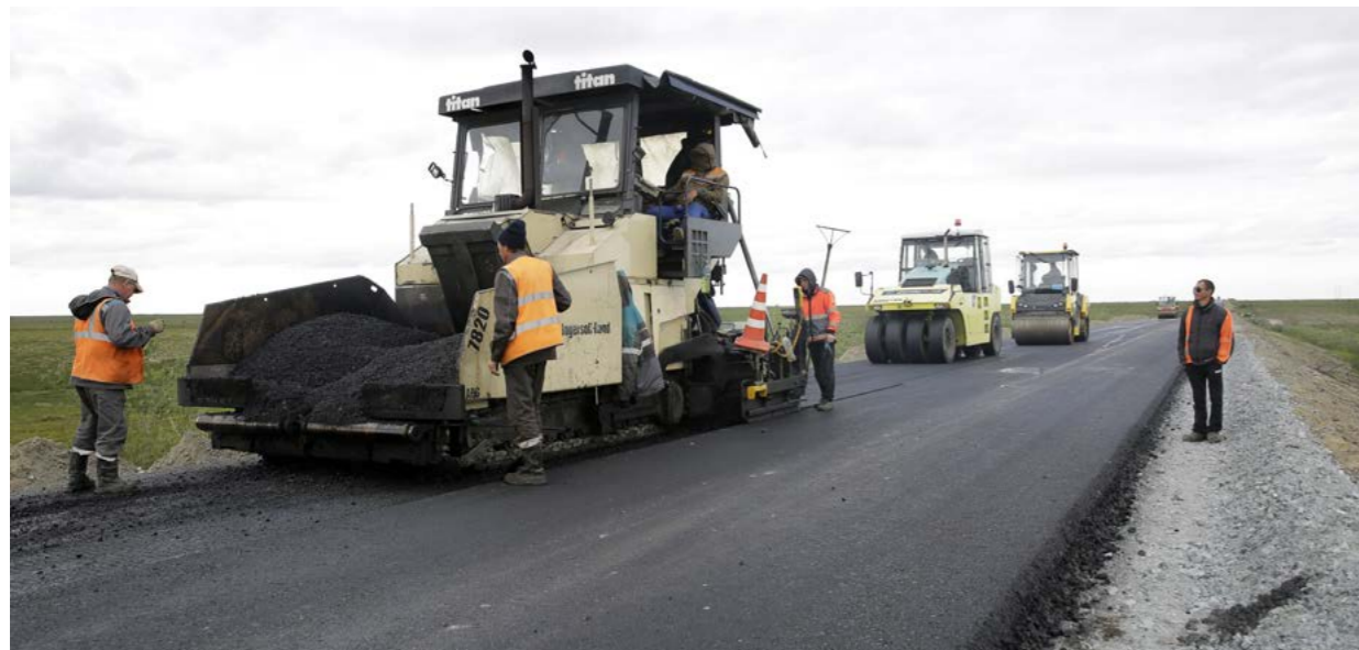
На участке дороги от Тазовского до Ново-заполярного подрядчик завершает капитальный ремонт 15 километров пути, 12 из них уже заасфальтированы
