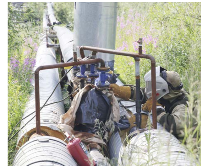
Коммунальщики переподключают потребителей к новой сети тепловодоснабжения от рыбозавода до спортшколы
