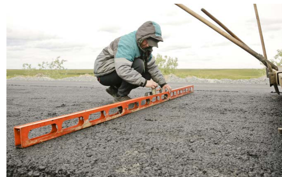
Рабочие с помощью дорожной рейки «Кондор» измеряют уклон дороги: в обе стороны он должен составлять по 1,5 градуса
