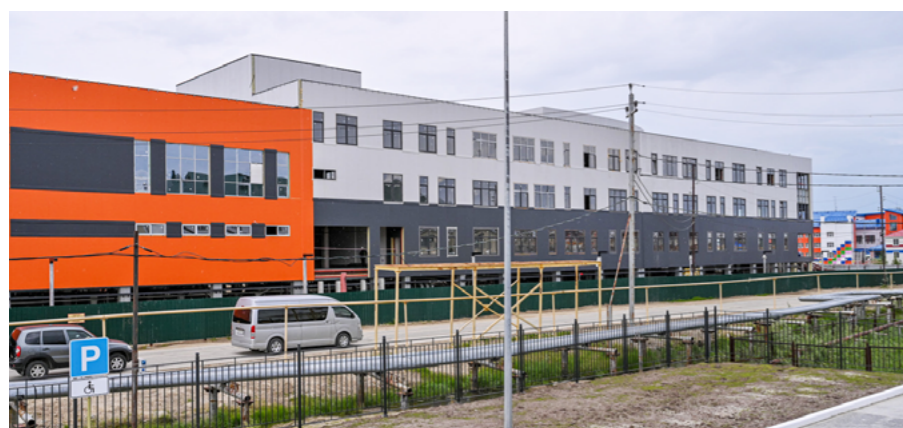
Готовность новой школы, которую в Тазовском возводит Северная строительная компания, составляет 50 процентов
