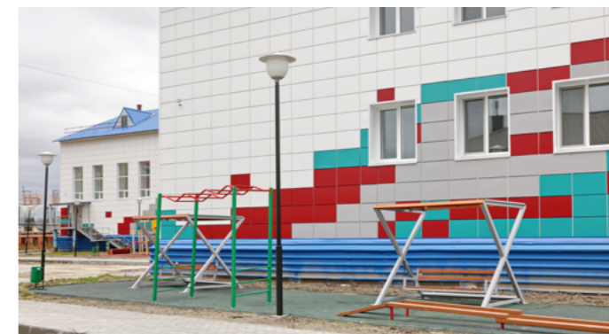
После реновации здание учебного корпуса начального звена Тазовской школы-интерната не узнают - строители заменили фасады и витражами закрыли входную группу
