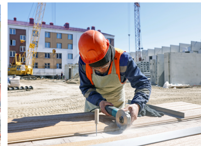
Специалисты компании «Рус Арктик Строй» завершают фасадные работы на втором доме из шести, строящихся в рамках третьей очереди Солнечного. Внутри здания уже работают отделочники
