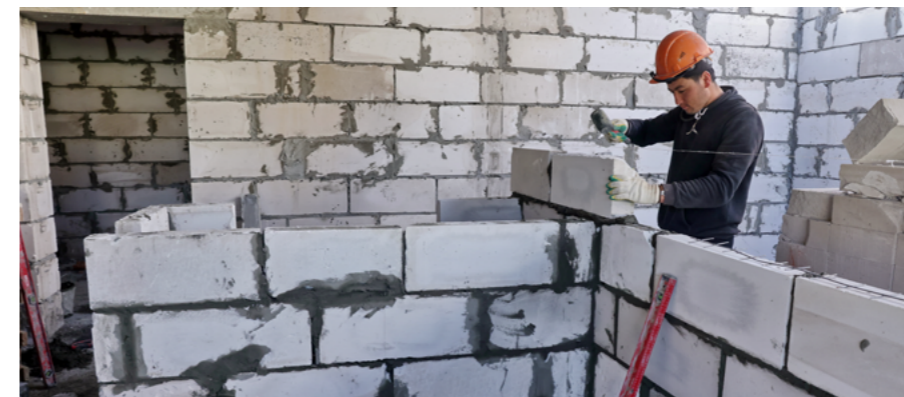
В микрорайоне Калинина продолжается возведение двух домов на 121 квартиру для участников программы переселения из аварийного жилья. Подрядчик обещает сдать новостройки к концу года
