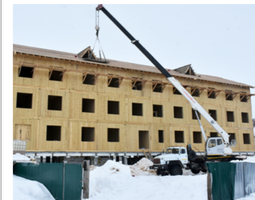
Ввод в эксплуатацию 22-квартирного жилого дома запланирован на конец этого года
