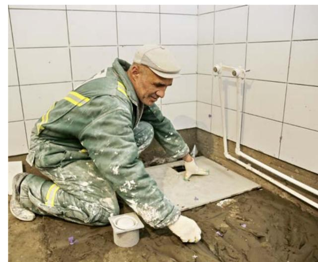
В санузлах и на лестничных пролётах плиточники занимаются укладкой плитки, для каждого помещения она своя. Например, на лестницах используют керамогранит
