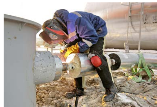
Уже смонтированы пожарные резервуары на территории школы, сейчас их подключают к инженерным сетям
