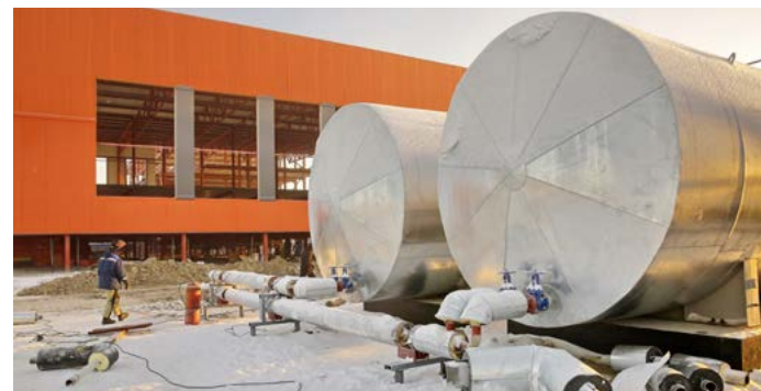
Под новой школой строители делают конвертовку, для предотвращения растепления свайного основания. Для этой же цели под всем зданием забурили 772 трубки с хладагентом
