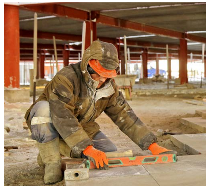
Под новой школой строители делают конвертовку, для предотвращения растепления свайного основания. Для этой же цели под всем зданием забурили 772 трубки с хладагентом
