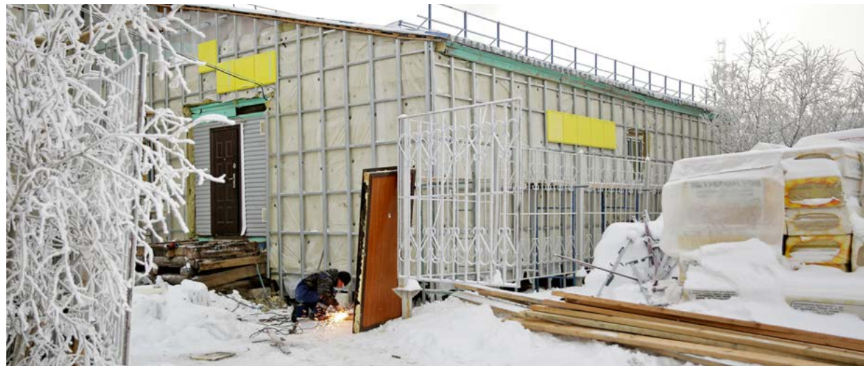
Сейчас строители занимаются облицовкой здания спортшколы, на фасад монтируют металлокасеты
