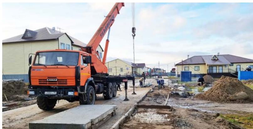
На примыкании улиц Снежной и Полярной завершается ремонт дороги и перекладка тротуара, протяжённостью 300 метров
