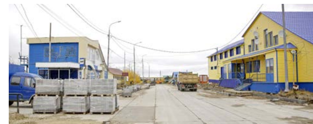
Работники дорожно-транспортного предприятия завершают капитальный ремонт участка дороги по улице Почтовой
