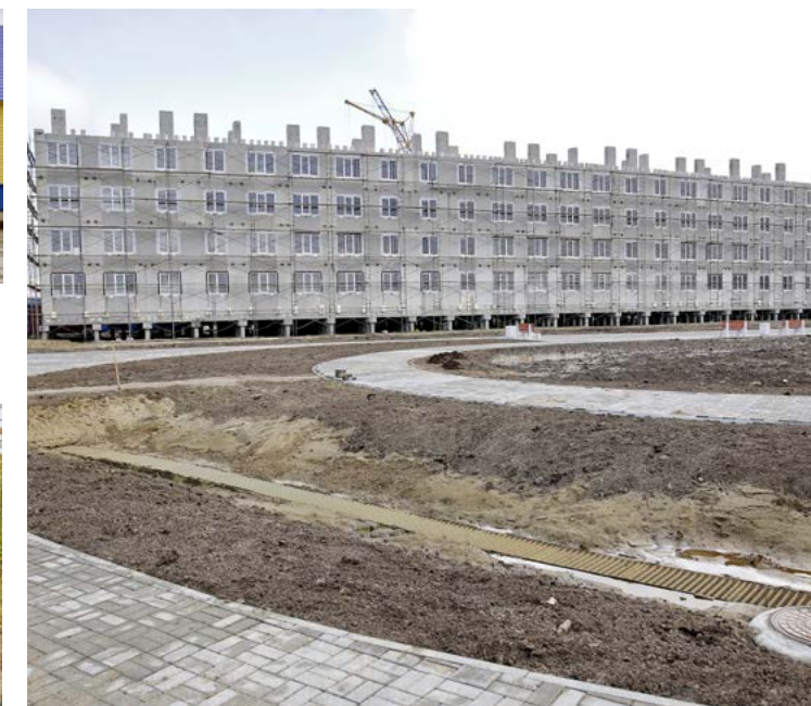
В этом году завершаются работы по благоустройству всего микрорайона Солнечного. Подрядчик уже выложил проезды и пешеходные дорожки, установил МАФы, осталось устранить замечания
