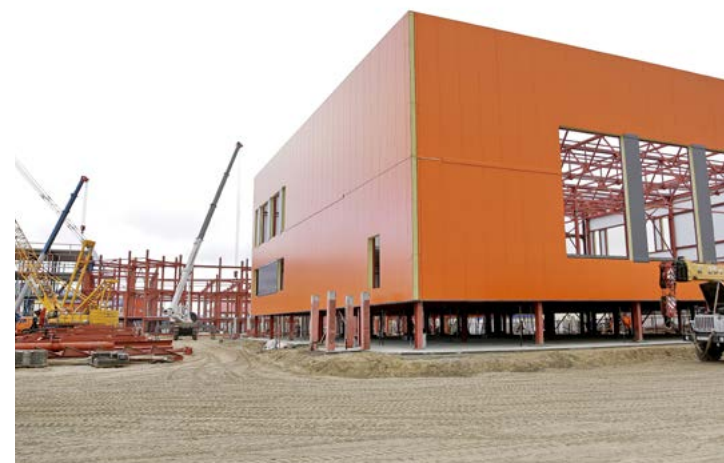
Специалисты ССК практически завершили работы по монтажу панелей первого из четырёх блоков - здесь расположатся большой спортзал, а над ним тренажёрный зал
