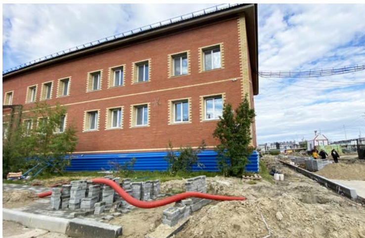
На территории корпуса будут установлены две площадки, сделано освещение и водоотведение
