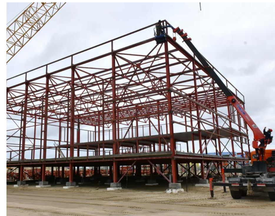
На объекте «Школа на 800 мест» выполняется монтаж несущего металлокаркаса. Новое учреждение образования будет построено в конце 2023 года
