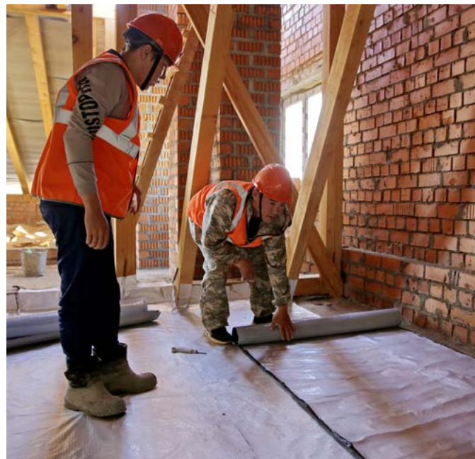
На чердаке строители утепляют перекрытия
