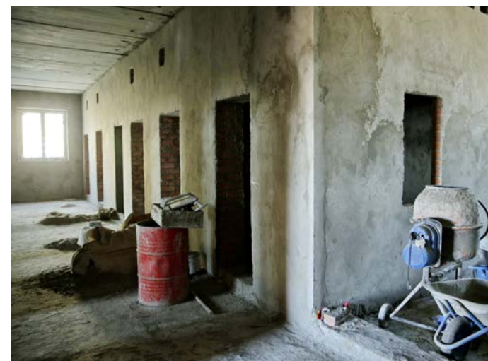
Внутри строители занимаются черновой отделкой
