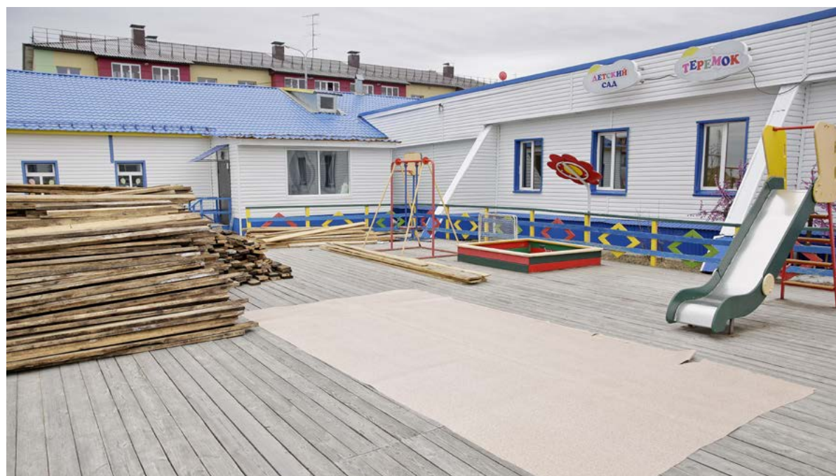
Детский сад «Теремок» в новом учебном году встретит воспитанников полностью обновлённым. Рабочие укрепят свайное основание, утеплят полы, произведут внутреннюю отделку стен с использованием огнестойких материалов
