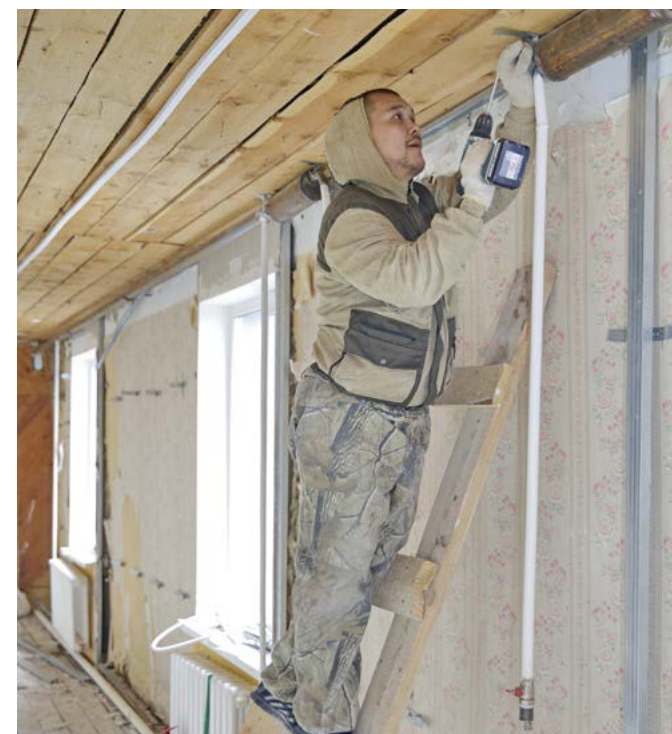
Внутри здания детского сада «Теремок» полным ходом ведутся демонтажные работы
