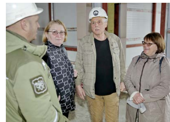
Марина Кравец обсудила со строителями темпы возведения спального корпуса в Гыде
