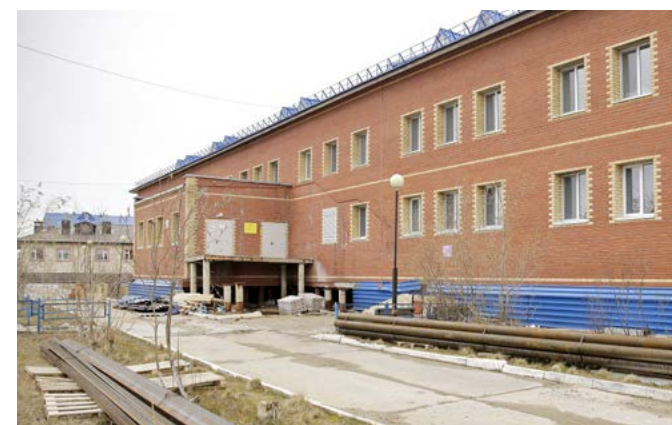
Капитальный ремонт корпуса школы-интерната ведётся с августа прошлого года. В настоящее время рабочие подрядной организации демонтируют крыльцо
