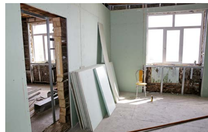
В Находкинской школе-интернате ремонтные работы на стадии внутренней отделки
