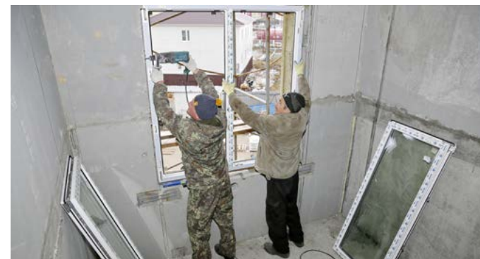
С наступлением тепла на объектах возобновились работы, сейчас строители устанавливают окна и готовятся монтировать фасады
