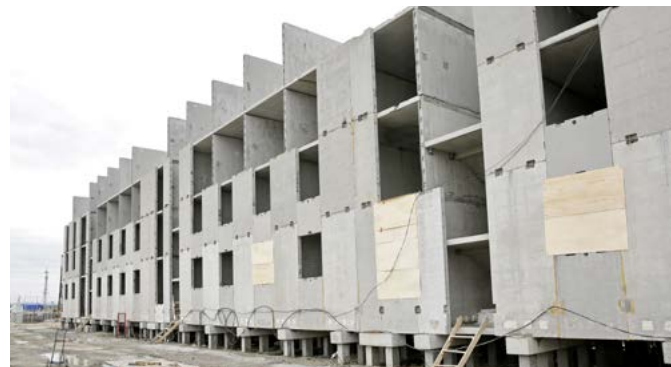
На третьей очереди Солнечного пока высятся каркасы одного из шести домов. Но уже к концу лета здесь планируется возвести и закрыть тепловой контур трёх четырёхэтажек
