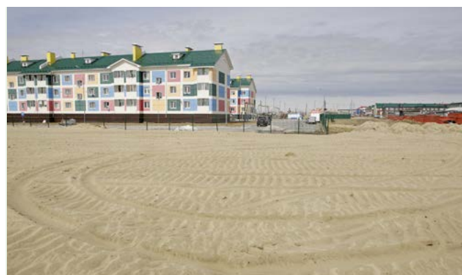
В микрорайоне Подшибякина к двум не так давно построенным домам через пару лет добавятся ещё два. Компания «Рус Арктик Строй» уже выполнила вертикальную планировку
