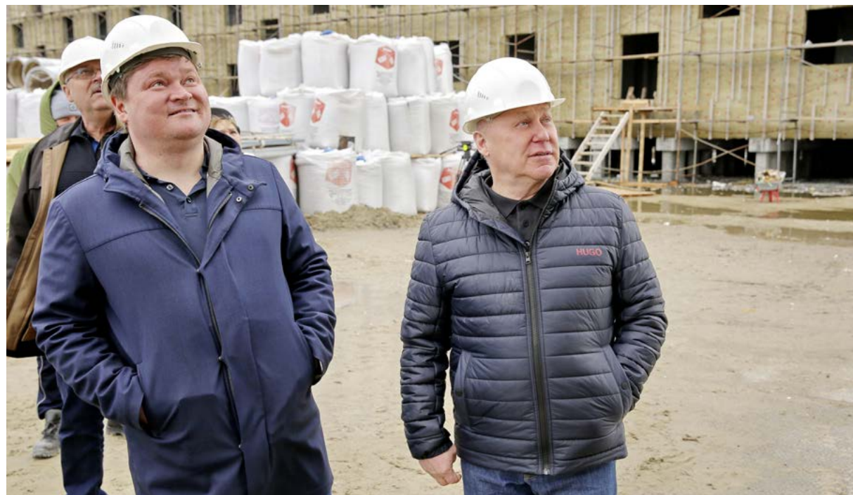
Глава района Василий Паршаков и исполнительный директор ООО «Рус Арктик Строй» Егор Лохман на стройплощадке по улице Геофизиков оценивают ход работ
