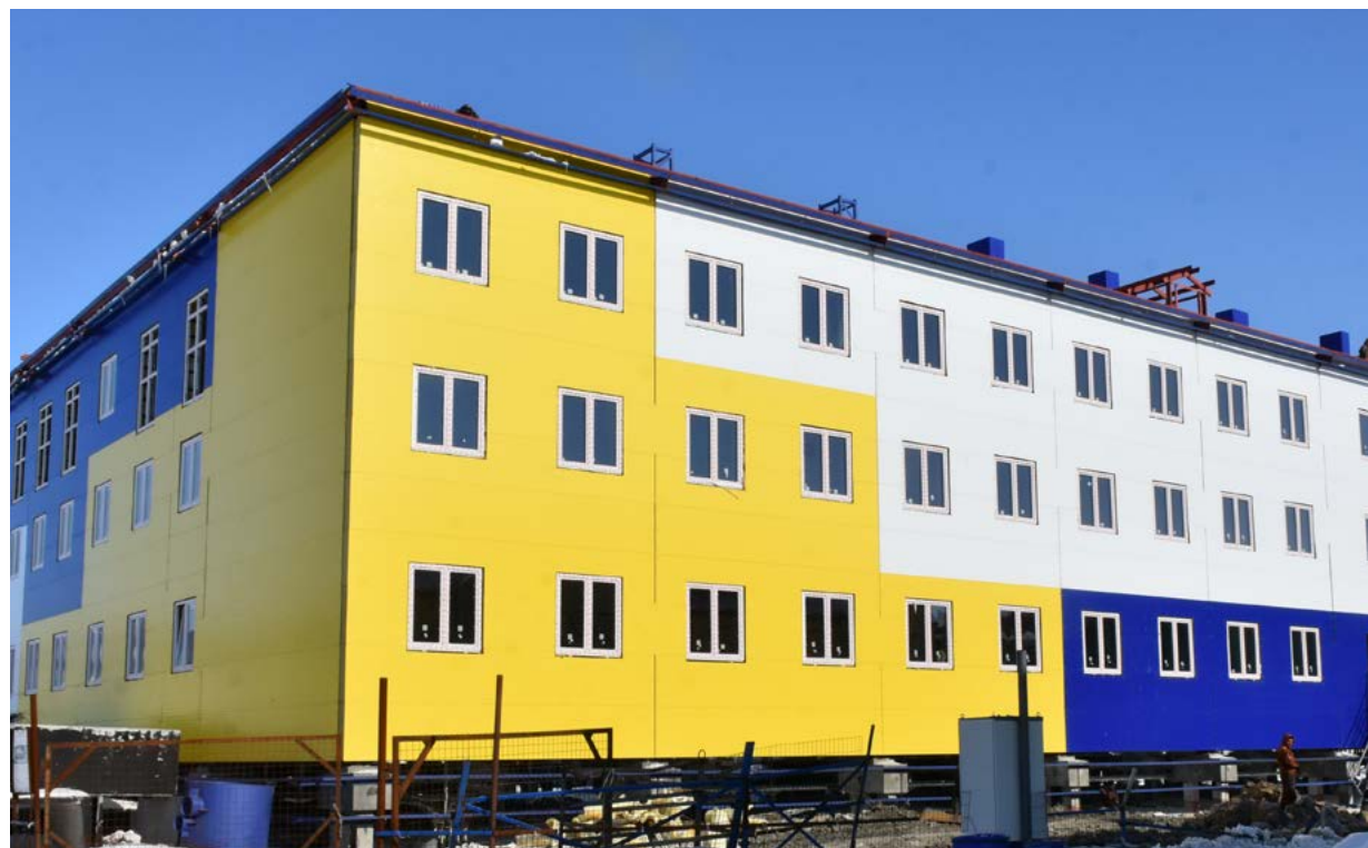
До 2024 года ООО «Северная строительная компания» планирует возвести в Гыде два спальных корпуса на 600 мест
