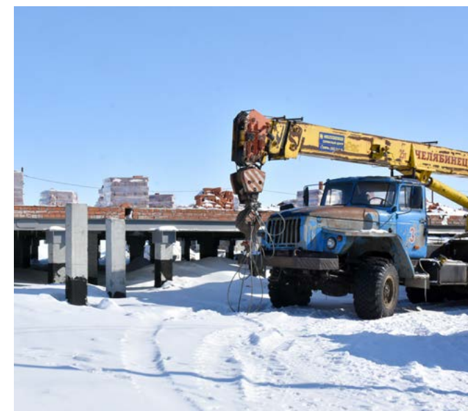
Большую часть строительных материалов для новой участковой больницы ГСМП «Строитель» закупило ещё в прошлом году. Сейчас рабочие занимаются кладкой стен и монтажом перекрытий
