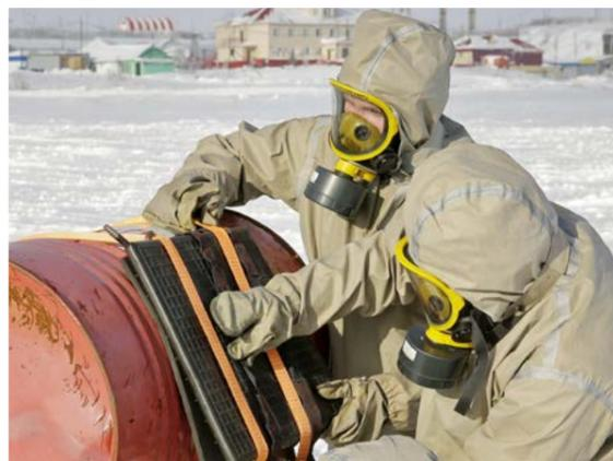
Звено газоспасателей устанавливает пневмопластырь на резервуар, чтобы устранить утечку
