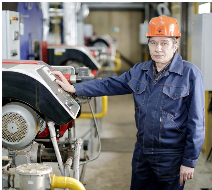
На фото: оператор котельной Дмитрий Аксёнов
