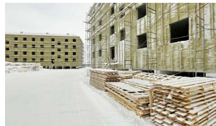
На стройплощадке в Геофизиках пока тишина, застройщик ждёт поставки оконных блоков, чтобы возобновить наружные работы и приступить к внутренней отделке
