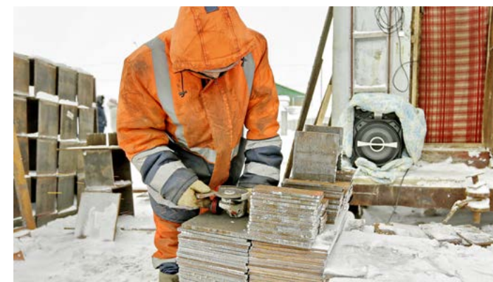
На улице Пиеттомина подрядчик - строительное объединение «Арктика» - монтирует ростерк в основании 99-квартирного четырёхэтажного дома
