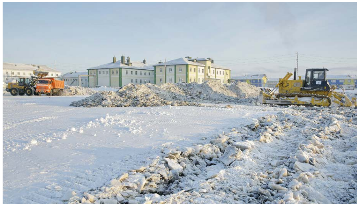
В районе поликлиники началась подготовка площадки для строительства больничного комплекса
