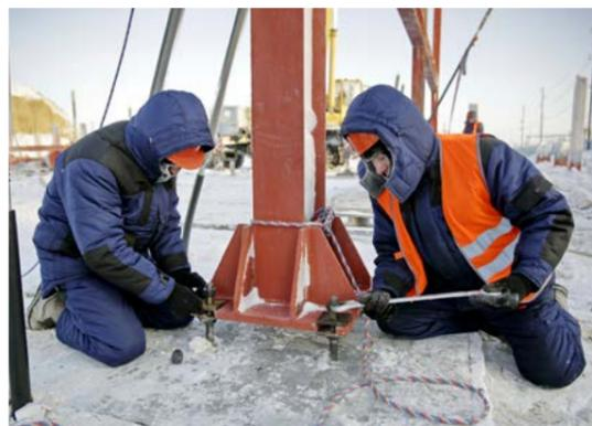
Строители ССК заканчивают обустройство свайного основания и приступают к монтажу металлоконструкций
