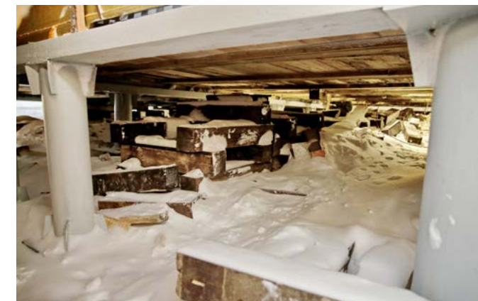
Первое, с чего начали строители, зайдя на объект, - усиление свайного основания, поскольку старые деревянные сваи не выдерживали никакой критики
