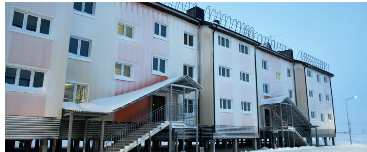
Многоквартирный жилой в Антипаюте строители обещают сдать в конце января 2022 года. Сейчас там завершается внутренняя отделка
