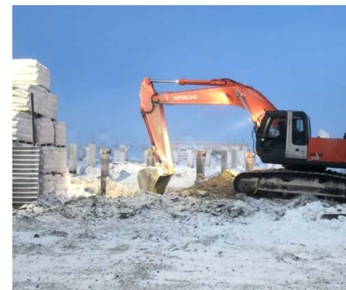
В Гыде завершено обустройство свайного поля под здание участковой больницы на 11 коек с врачебной амбулаторией на 35 посещений в смену
