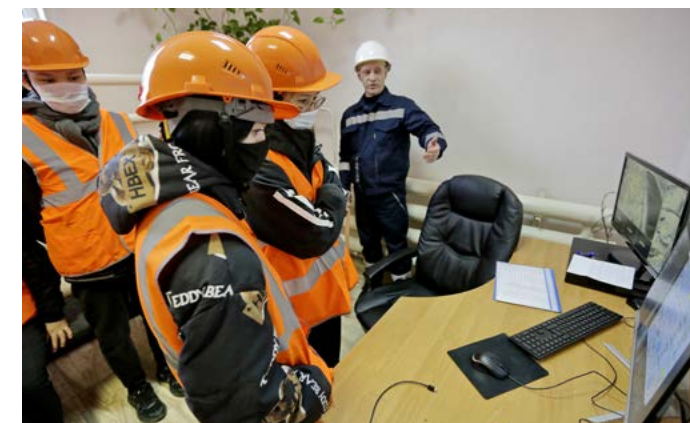
Так выглядит рабочее место оператора станции водоочистки: стол и компьютер, с которого управляют системой очистки воды
