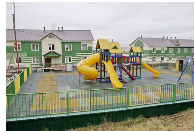
В этом году по улице Подгорной отремонтировали детскую площадку
