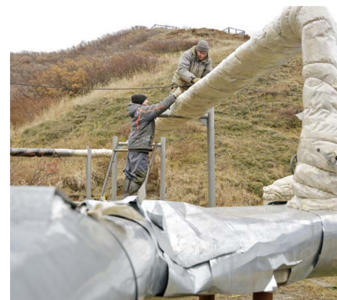
Новая сеть обеспечит дома по улице Подгорной теплом и водой
