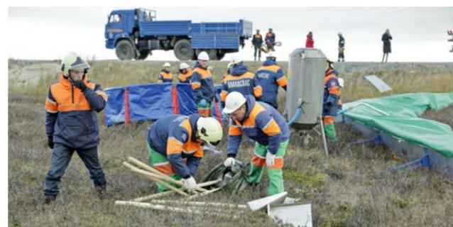
Для предотвращения дальнейшего разлива нефтепродукта спасатели собрали подпорную стенку, а также использовали вакуумные установки для сбора жидкости, мобильные резервуары и искробезопасные лопаты
