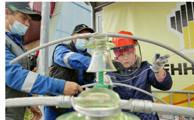
Школьница Анна Чужикова попробовала сделать спиральную вязку для крепления к изоляторам
