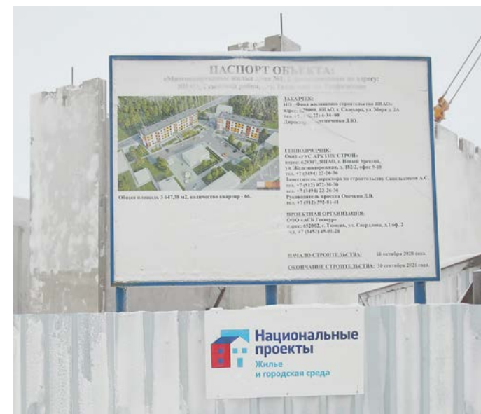
В июне 2020 года на улице Геофизиков забили первую сваю под 24-квартирный дом, сейчас здесь практически собран первый этаж. Сдать объект подрядчик намерен уже осенью
