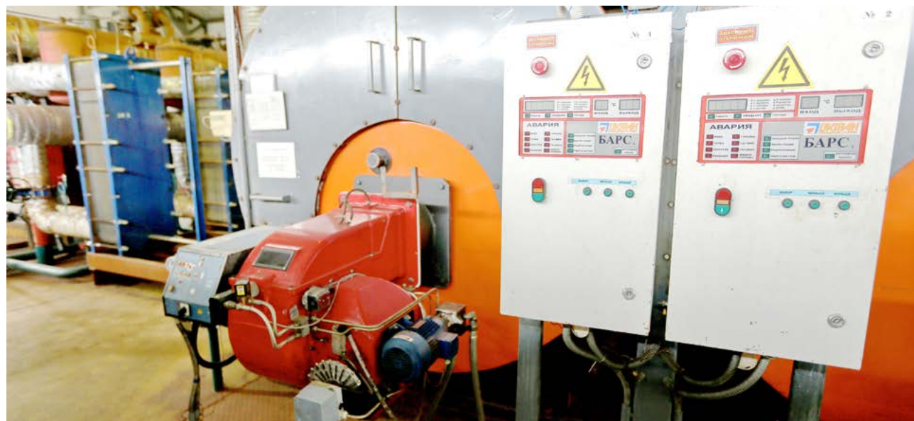
На котельной № 2 в Тазовском все работы завершены и четыре котла готовы к работе
