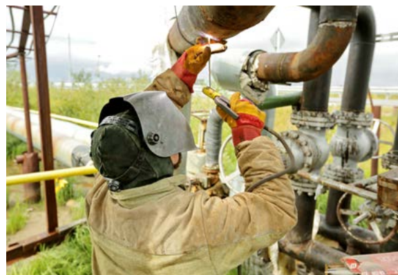
На прошлой неделе завершались работы на сетях в райцентре котельной № 5
