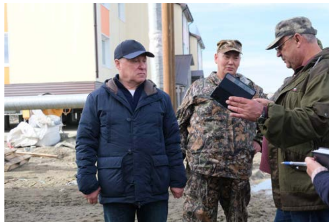
Сейчас в Антипаюте возводят четыре многоквартирника, Глава осмотрел стройплощадки
