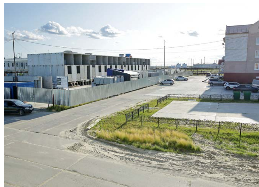
В микрорайоне Маргулова строится 39-квартирный дом для переселения граждан из аварийного жилья
