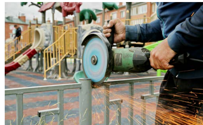
Демонтаж ограждения детской площадки по адресу: Пушкина, 10
