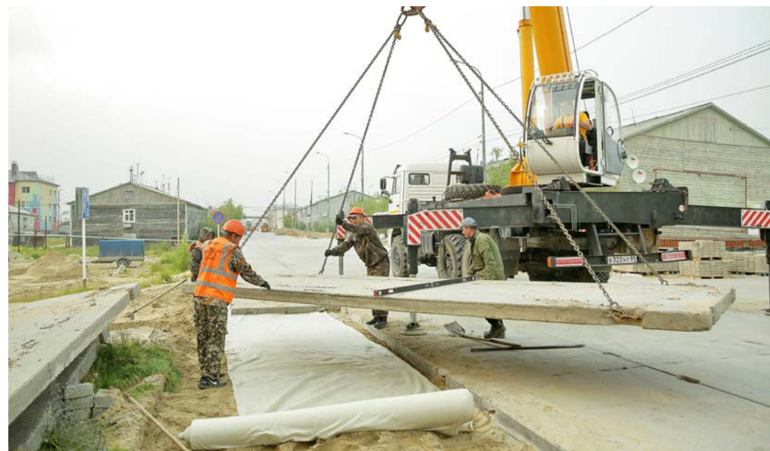
Чтобы обеспечить неподвижность плит, швы сваривают, а щели заливают специальным раствором
