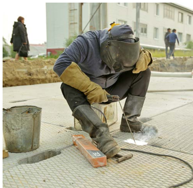
Чтобы обеспечить неподвижность плит, швы сваривают, а щели заливают специальным раствором
