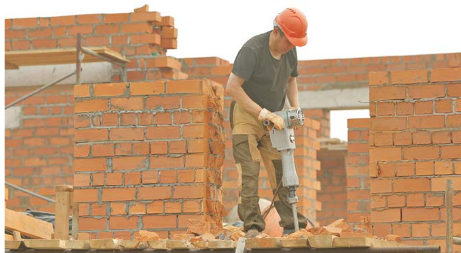
Сейчас на объекте продолжается возведение стен первого этажа
