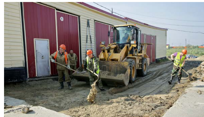
После переукладки плит перед боксом на четыре выезда туда загонят спецтехнику
