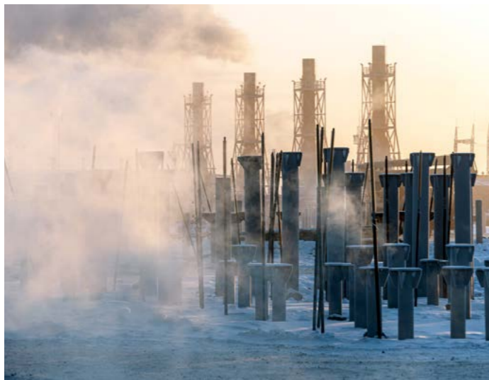
Ноябрь 2019 года. Строительство ДКС ГП-1С ЗНГКМ
