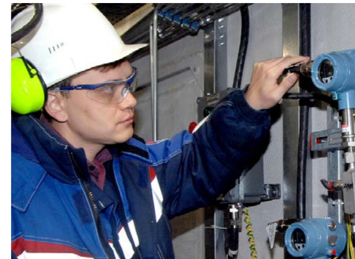
Ноябрь 2018 года. Внутри модульной компрессорной установки на кустовой площадке ГП-6
