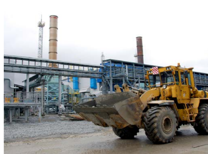
Сентябрь 2016 года. Строительство ДКС газового промысла № 9
