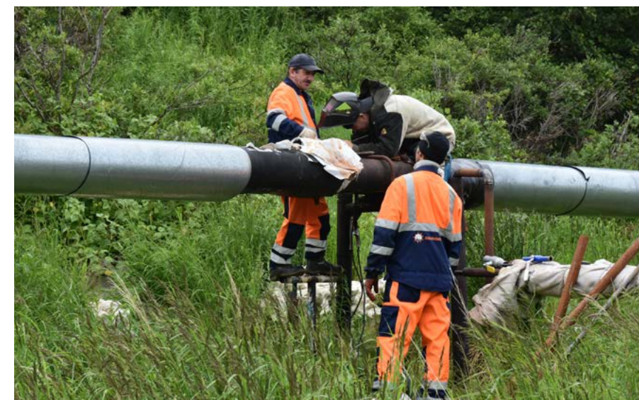
Всего в райцентре этим летом отремонтируют восемь участков теплосетей
