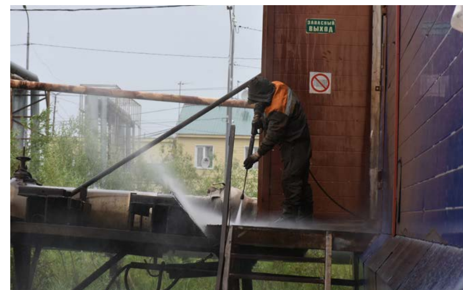
Пластины теплообменников промывают несколько раз в год, чтобы сохранить теплоотдачу для потребителей
