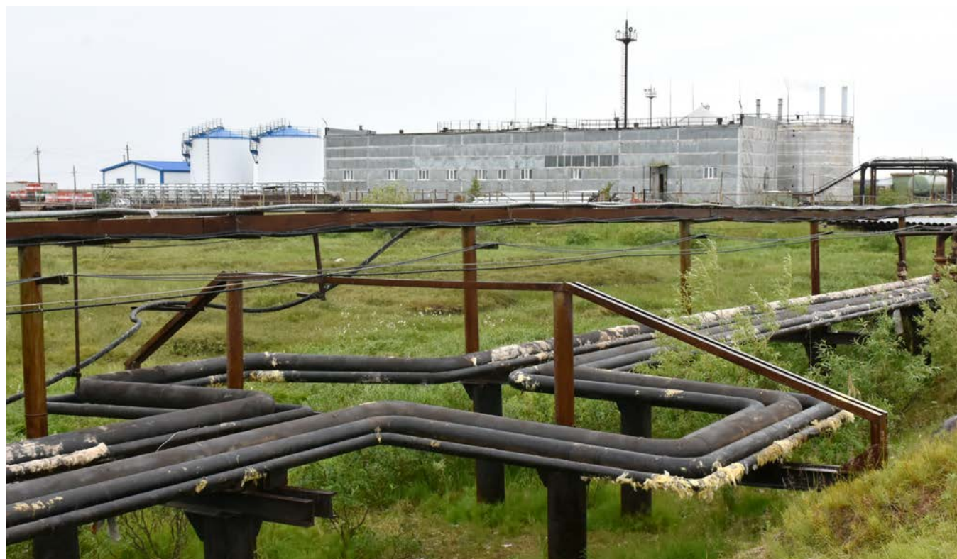
Трубы на теплосетях, идущих от котельной Термакс, заменят на больший диаметр
