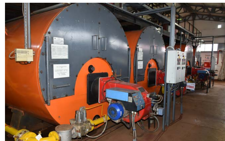
На котельной № 2 в Геофизиках уже провели гидравлическую опрессовку и испытания котлов
